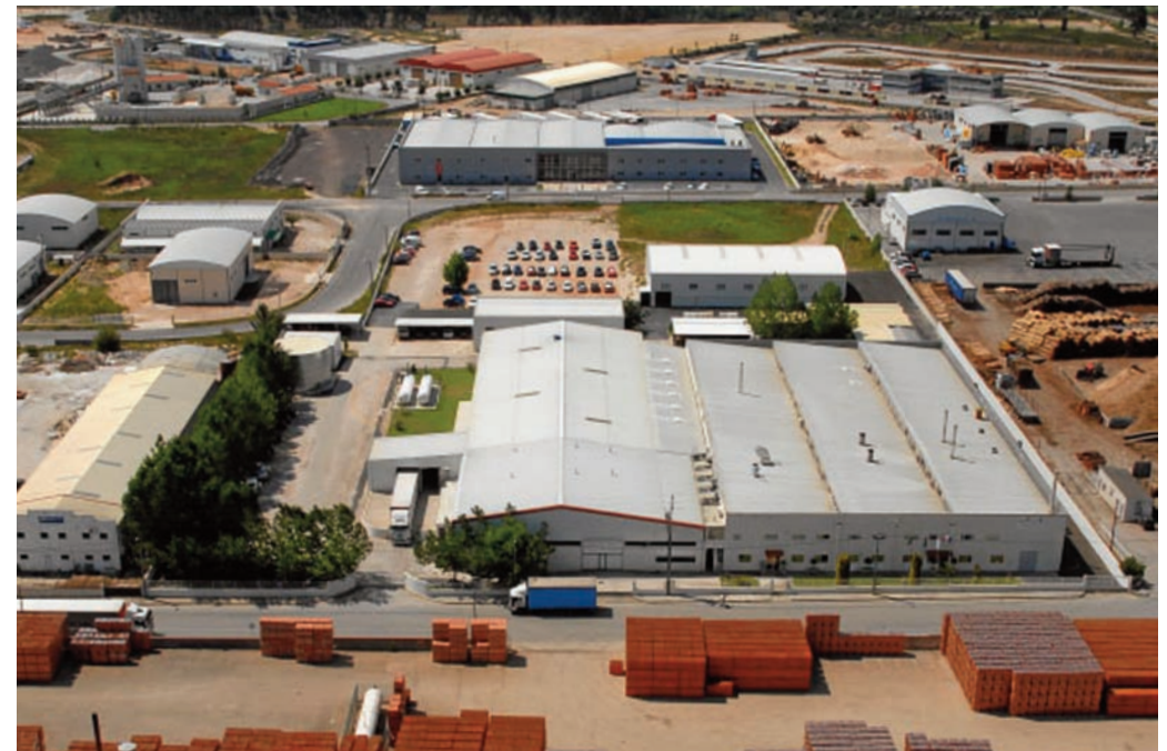
Usine du Portugal
